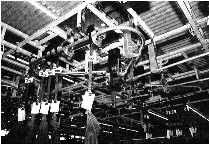
Ausschnitt einer High-Tech-Anlage
