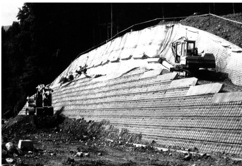
Hangsicherung der Zürcher Sihltalbahn: Die fertig erstellte Textomur-Konstruktion ohne Begrünung. Bild: Fritz Landolt AG, 8752 Näfels
