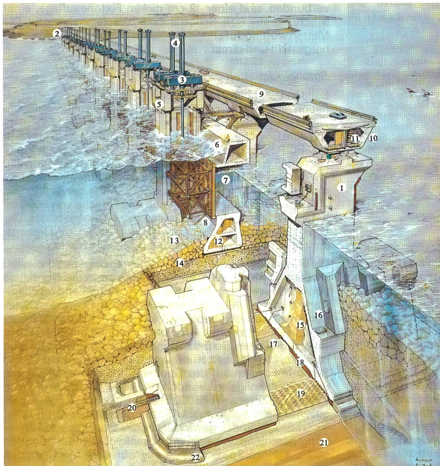
Bild 6 Die bewegliche Sturmflutbarriere besteht weitgehend aus vorgefertigten Bauelementen:
