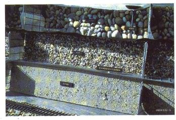
Schnitt durch die als Filter aufgebaute Fundierungsmatratze. Aufbau der Matratze:
