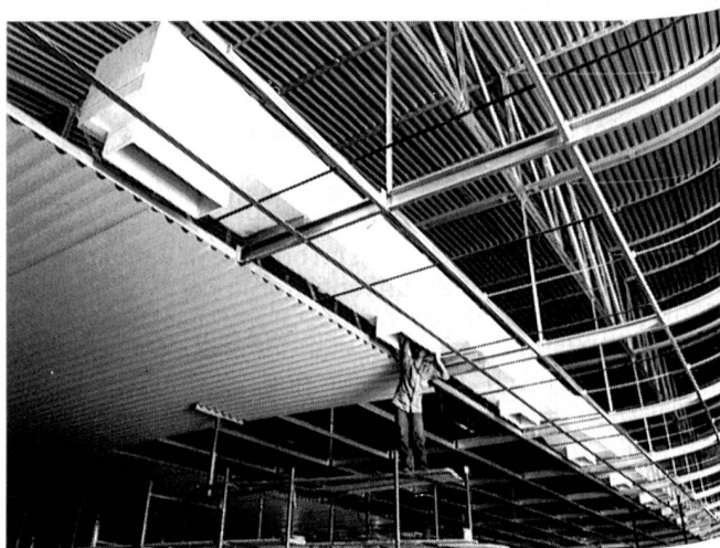
Montage von Deckenkanälen für eine Weberei im pazifischen Raum
