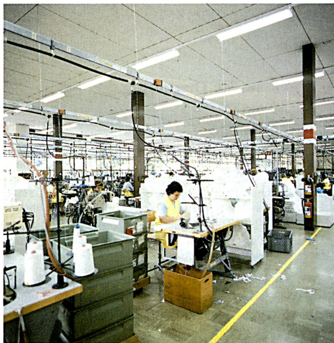
Moderne, mit Reflektoren ausgestattete Lichtleisten an Montageschienen bieten in der Näherei der SIDEMA SA, Lugano, einen zeitgemässen Beleuchtungskomfort. Gleichzeitig reduzieren sie den Energieverbrauch der Beleuchtungsanlage auf weniger als die Hälfte des bisherigen Wertes. (Foto Zumtobel AG)
