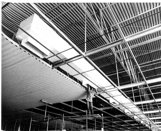
Montage von Deckenkanälen für eine Weberei im pazifischen Raum (Foto Sulzer, Nr. 0287 0075-5)
