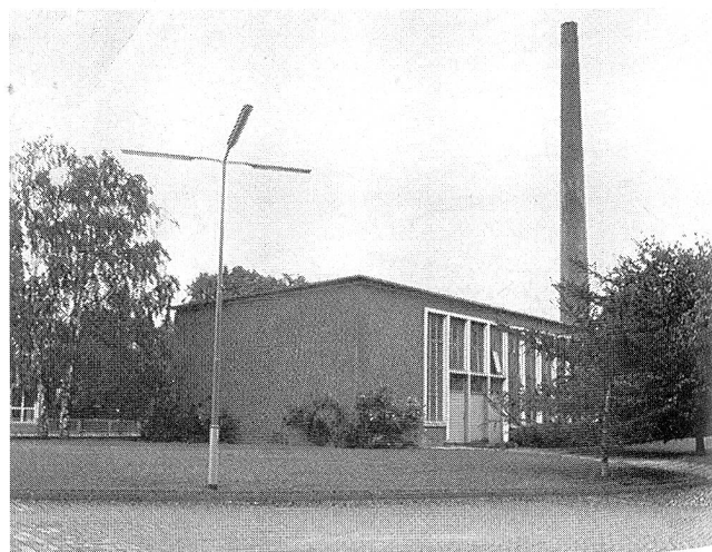
Bild 1: Kesselhaus der Filztuchfabrik
