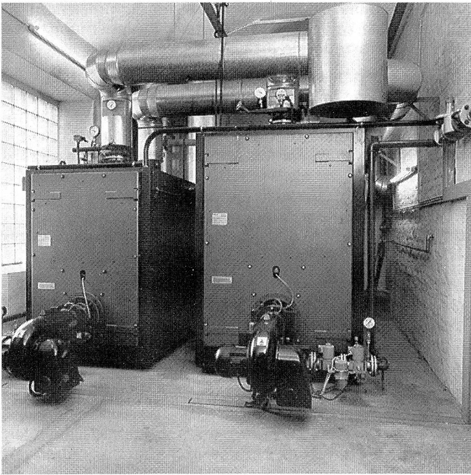
Bild 3: Neue dezentrale Kesseleinheiten
