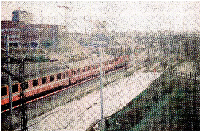
Schüttung vom Unterbau auf die verlegten mechanisch vernadelten Trevira Spunbond-Vliese Typ 11/360 aus endlosen Polyesterfäden von Hoechst. Foto: A. Locher AG
