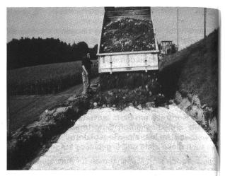
Geotextilien im Strassenbau. Nadelvlies. 1986 sollen weltweit üb. 400 Millionen Quadratmeter verschiedenartigster textiler Flächen, bilde im Bauwesen eingesetzt worden sein.
