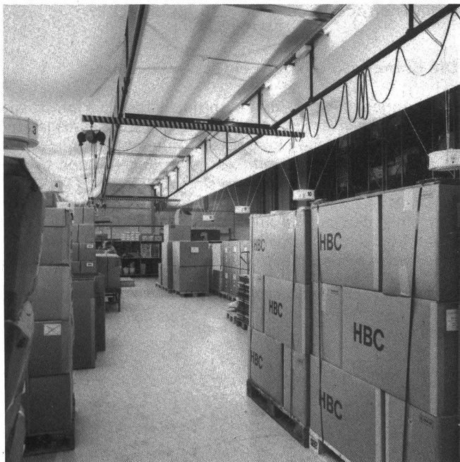
Im Grenzbereich zwischen Lager und Spedition ist richtig verstandener Brandschutz doppelt wichtig. Die Melder an der Decke sorgen für frühe Warnung, sobald Gefahr auftritt. (Foto Cerberus)
