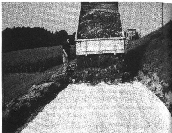
Geotextilien im Strassenbau. Nadelvlies. 1986 sollen weltweit über 400 Millionen Quadratmeter verschiedenartigster textiler Flächenbilder im Bauwesen eingesetzt worden sein.
