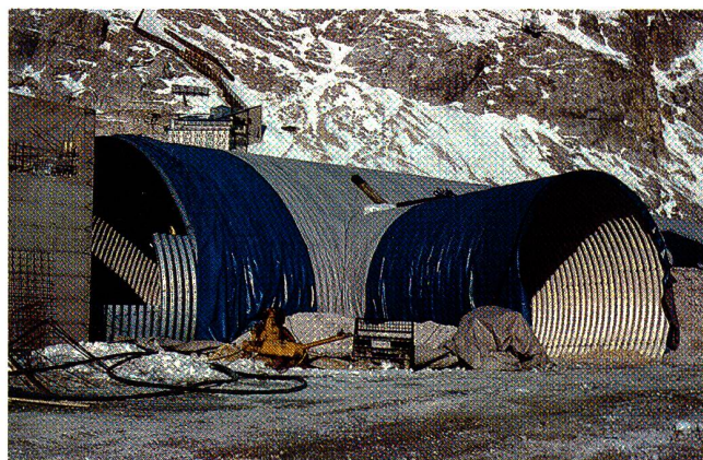
Eingangs-/Ausgangsbereich der Bahnsteighalle mit dem PVC-beschichteten Trevira® Hochfest-Gewebe, beidseitig mit Trevira® Spunbond-Geotextilien abgedeckt als Schutz gegen mechanische Beschädigung und gegen Wasser.
