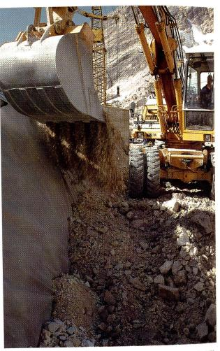
Auch beim direkten Beschütten mit scharfkantigen Steinen oder Blök ken wird die mit Trevira® Hochfest versehene Dichtungsbahn von Trevira® Spunbond vor Beschädigungen geschützt.
