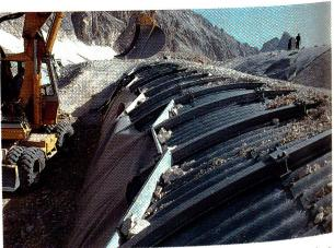
Die Ausgleichsschicht zwischen dem Geotextil und dem Bahnhofspro fil wird aufgebracht. Deutlich zu sehen ist das Profil mit den Trägern.
