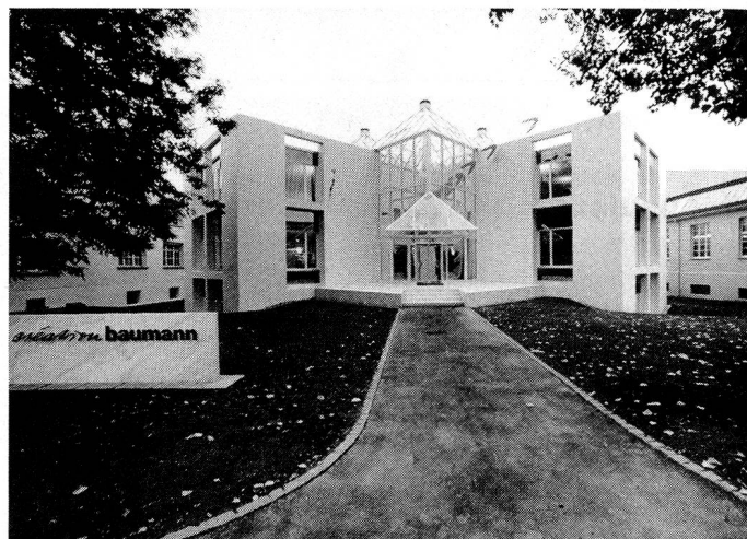
Das neue Bürohaus von Création Baumann
