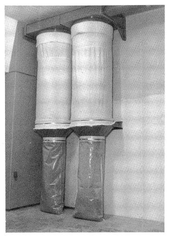
Abb. 4 Standard-Abscheider zur Sammlung von Staub und Fasern
