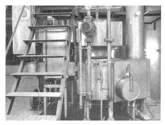
Bild 4 Abgaswärmerückgewinnung dank sauberer Erdgas-Abgase bei Cilander AG, Herisau: Die Abgase werden auf 20°C abgekühlt und damit 30°OO Liter Warmwasser à 50°C erzeugt. Energieeinsparung: über 10%.
