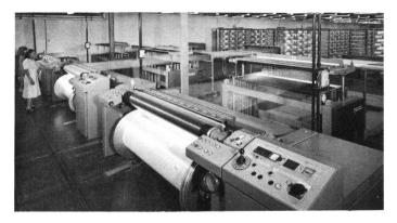
Breitzettelanlage mit Zettelmaschinen OZD für Filamente
