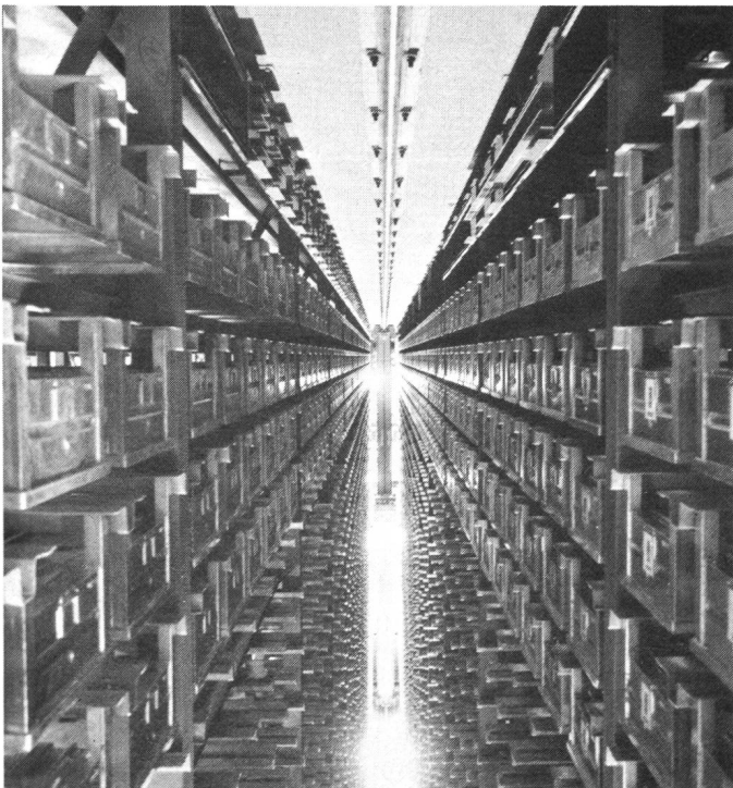
Regelbediengerät und Regale des Kleinteilelagers der Werkzeugmaschinenfabrik Oerlikon Bührle AG; 6 automatisch gesteuerte Geräte erfassen 45 000 Behälter.
