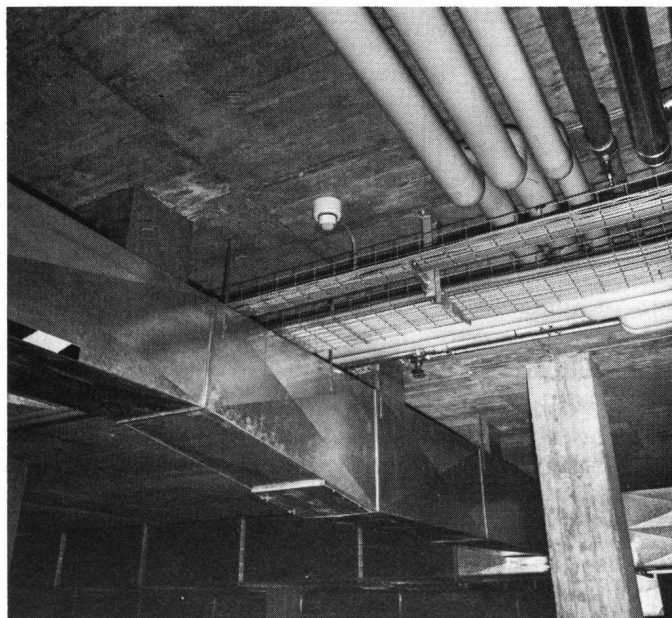
Kaum eine Industrie wie die Textilverarbeitung ist in allen Bereichen durch Brandrisiken derart gefährdet. Es entspricht deshalb erfahrenerem Handeln, wenn selbst in Untergeschossen im Bereich von Luftkanälen und elektrischen Leitungen automatische Brandmelder zur dauernden Überwachung eingesetzt werden (Foto Cerberus)
