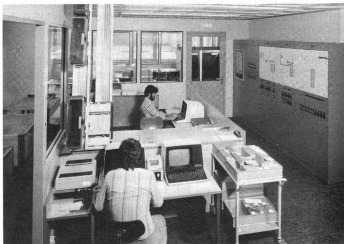
Ein leistungsfähiges Verwaltungsrechner-System unterstützt in diesem Lager die Ein- und Auslagerungsvorbereitung, verwaltet die Lagerbestände und übernimmt die Montageaufträge der zentralen EDV. Die Resultate, in Tagespaketen, werden vom Steuerungsrechner übernommen und verarbeitet.
