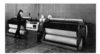
Der Schusseintrag im Zweiphasen-Prinzip, eine Konstruktionsidee, welche hohe Eintragsleistungen von 1036–1184 m/min bei niedriger Fadengeschwindigkeit und Maschinendrehzahlen zwischen 280–325 min<sup>-1</sup> erlaubt. Daraus ergeben sich weitere Vorteile wie kontrollierter Abzug und Führung des Schussfadens, sinusförmiger Bewegungsablauf und somit geringere spezifische Belastung des Schusses.
