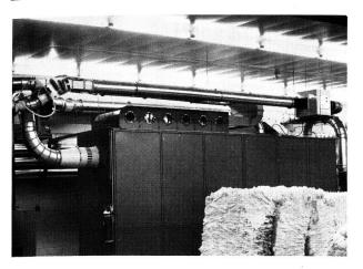
Über der Mischmaschine «Unimix» ist rechts der Metalldetektor zu sehen. Die Rohrleitung führt zur Ausscheidevorrichtung links aussen.
