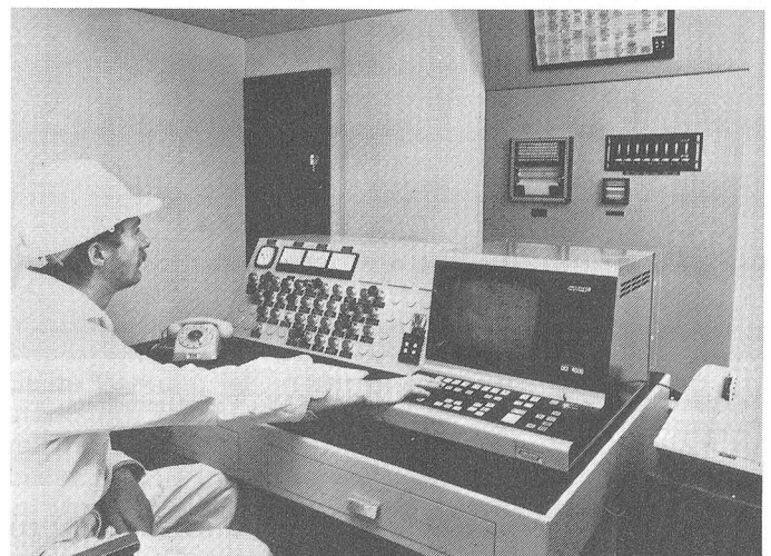
Von Fischer and Porter eingerichtete Kontrollzentrale für die Phosphin-Anlage von Albright and Wilson. Kernstück ist ein Mikrocomputer des Typs DCI 4000.
