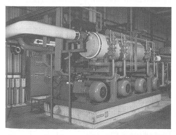
Elektro-Wärmepumpensatz «Liquifrigor» mit vier offenen Kolbenverdichtern für den ganzjährigen Betrieb. Kälteleistung 837 kW, Heizleistung im Winterbetrieb 865 kW bei 70 °C Heizwassertemperatur. Umschalten von Sommer- auf Winterbetrieb durch Handschalter. Foto: Sulzer Escher Wyss
