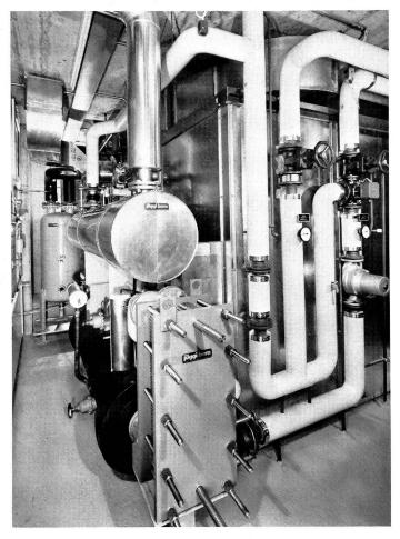
Nr. 4 Im Vordergrund Zylinderkühlwasser-Plattenwärmetauscher, dahinter Kältekreislauf-Kondensator und darüber Abgas-Rohrbündelwärmeaustauscher; im Hintergrund Schallschutzkapsel mit Abluftkanal
