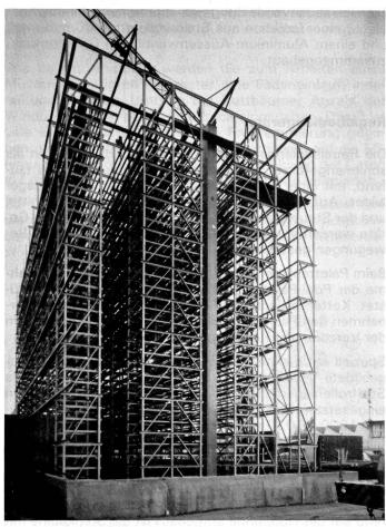
Während der Montage der Stahlkonstruktion wurden die Regalbediengeräte durch das offene Dach von oben eingebracht. Werkfoto Walter Stöcklin AG, Dornach
