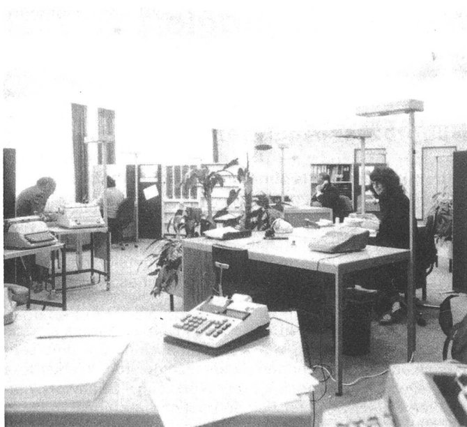
Bild 6: Grossraumbüro mit arbeitsplatzorientierter Indirektbeleuchtung durch hochstrahlende Tischleuchten mit Halogen-Metall-dampflampen. Man erkennt deutlich die lebendige Helligkeitsverteilung an der Decke und die Reduktion der Beleuchtung in der Hauptverkehrszone (rechts). Die Leuchten selbst (z.B. links vor der Pflanzengruppe und über der rechten hinteren Ecke des rechten Schreibtisches) fallen fast nicht auf.
