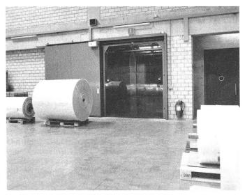
Noch zu wenig wird die Möglichkeit genutzt, die warnenden Impulse eines Brandmelders auch zu Steuerzwecken einzusetzen. Dieses Tor trennt zwei grosse Brandabschnitte. Bei Brandgefahr wird die Rückhaltevorrichtung automatisch entriegelt und macht damit den Brandabschnitt dicht. (Fotos Cerberus, Männedorf)
