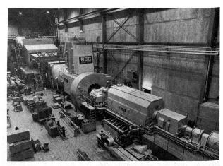
Die neue 25 MW-Gasturbinenanlage bei Ciba-Geigy Monthey: Von vorne nach hinten der Anlasser, der Generator, das Getriebe, die Gasturbine, darauf die Brennkammer mit Gas/Oel-Brenner, ganz hinten der Abhitzekessel.
