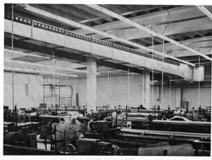
Uebersättigungsanlage in Webereisaal. Leistung: Luftmenge: 40 000 m $^3$ /h; Befeuchterleistung: 265 kg/h; Kühlleistung: 135 000 kcal/h bei 70  $^0$ /o rel. F.; Stromverbrauch: 5,2 kW.
