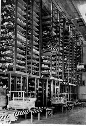
Abbildung 8 Regalbediengerät «Destamat» in einem Stoffballenlager
