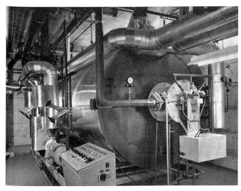
Thermoölkessel mit zweistufigem Gas-Gebläsebrenner, Leistung 2,5 Mio kcal/h, in der Zentralwäscherei Chur.
