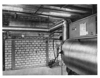
Oben der 2000 I-Boiler, der die Abgaswärme des Dampfkessels (rechts im Bild) der Textilreinigung AG Niederuzwil zurückgewinnt.
