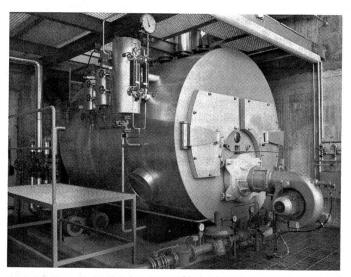
5 t-Dampfkessel der Firma Baumann Weberei und Färberei AG, Langenthal, mit zweistufig regulierbaren Gas/Oel-Zweistoffbrennern. Ein Teil der Kessel-Abgase wird zur CO<sub>2</sub>-Neutralisation verwendet.
