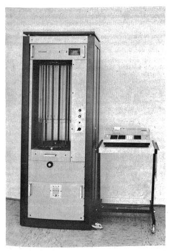
Abbildung 4 Kräuselkontraktions-Messgerät «Texturmat» mit Rechner
