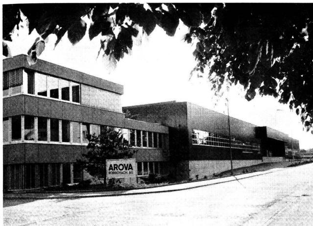
Die Aussenhaut besteht aus einer Stahlkassettenkonstruktion, die einen Schalldämmwert von etwa 45 dBA erreicht.
