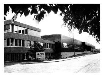
Die Aussenhaut besteht aus einer Stahlkasettenkonstruktion, die einen Schalldämmwert von etwa 45 dBA erreicht.
