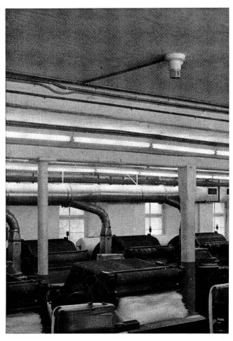
Die praktische Anwendung: der Melder auf unserem Bild sorgt dafür, dass, wenn in seinem Ueberwachungsbereich ein Feuer entsteht, dies sofort an die Löschequipen gemeldet wird. So ist es möglich, dass das Feuer bekämpft werden kann, noch bevor der Sachschaden grössere Ausmasse annehmen kann. (Foto Cerberus AG)
