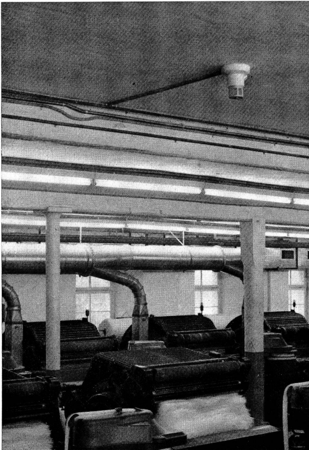
Die praktische Anwendung: der Melder auf unserem Bild sorgt dafür, dass, wenn in seinem Ueberwachungsbereich ein Feuer entsteht, dies sofort an die Löschequipen gemeldet wird. So ist es möglich, dass das Feuer bekämpft werden kann, noch bevor der Sachschaden grössere Ausmasse annehmen kann. (Foto Cerberus AG)
