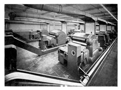
Abbildung 8 Rieter «Aerofeed» Kardenspeisesystem mit Regulierstrecke, 1970
