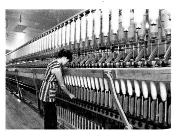
Ringspinnmaschine mit Doffer: Die neuesten Spinnmaschinen nehmen auch die vollen Kopse maschinell ab
