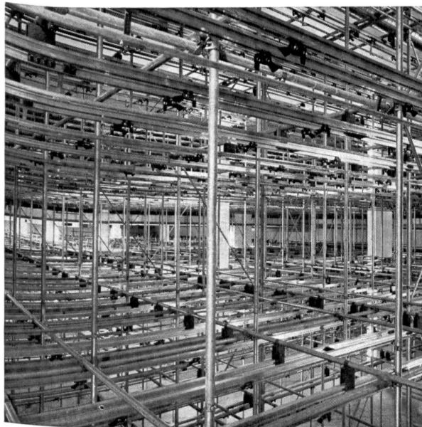
Blick auf 4etages Hängewarenlager während der Montage
