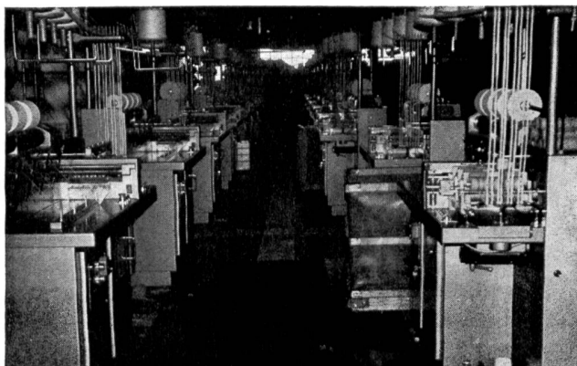
Abbildung 12 Grössere Self-Twist-Spinnanlage in einer Kammgarnspinnerei
