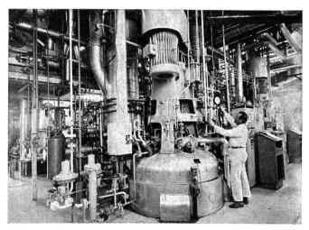
Polyesterproduktion: Polykondensationsgefässe (Reaktoren) (Werkfoto Emser Werke)
