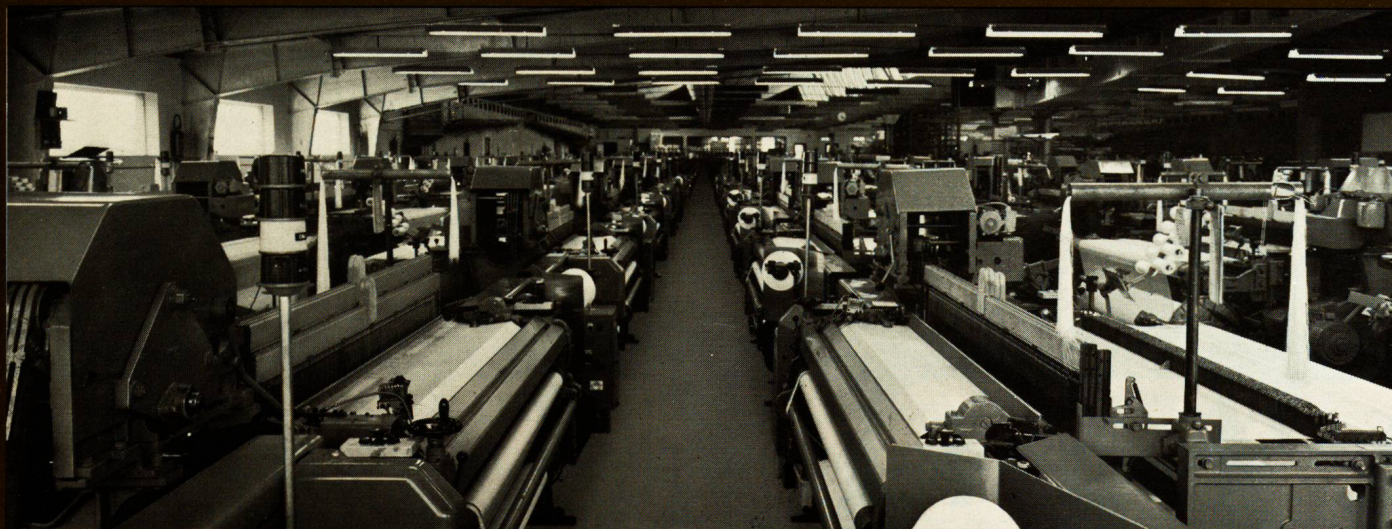
Weberei mit schützenlosen Einfarben-Webmaschinen Typ VERSAMAT
