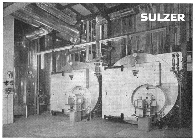
2 Sulzer-Dreizugkessel mit automatischer Ölfeuerung in einer chemischen Fabrik. Leistung je Kessel 12,8 bis 16 t/h Sattdampf, Betriebsdruck 12 atü.
