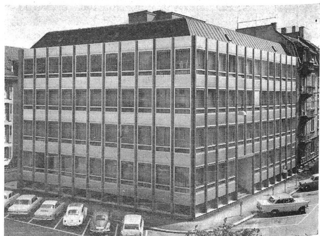
Neubau der Firma Adolphe Bloch Söhne AG, Zürich (ABZ), Tochterfirma der Weberei Wängi AG
