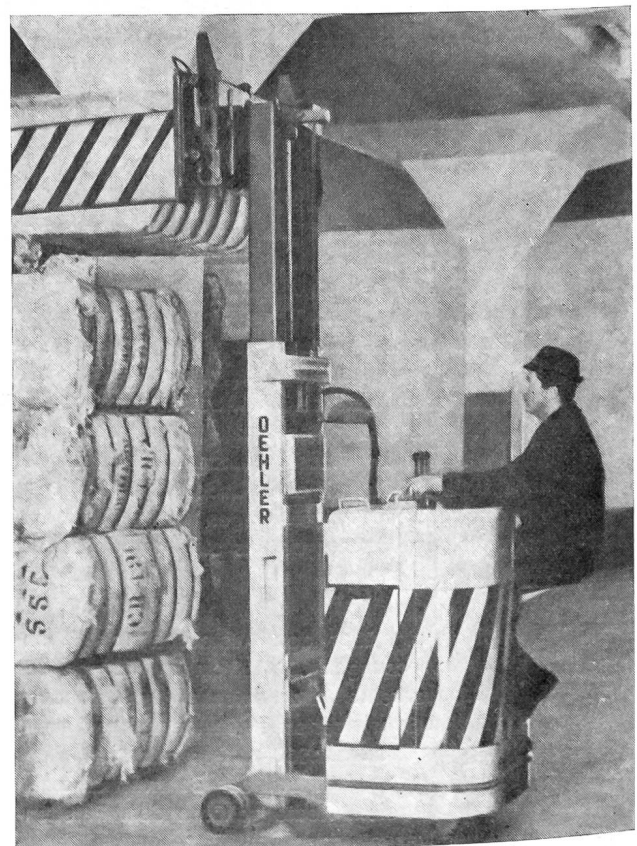
Bild 1 Stapeln der Rohstoffballen
