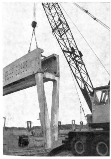
Beide Seitenteile sind nun hochgehoben und werden mit-<sup>ein</sup>ander verankert. Die Träger werden über den Stützen mit diagonalen Spannschlössern verbunden; ihr Abstand wird durch horizontale Rohre gehalten. Auf den Stützen sind sie so aufgelagert, dass weder die Kantenpressungen noch Horizontalkräfte unkontrolliert auftreten
