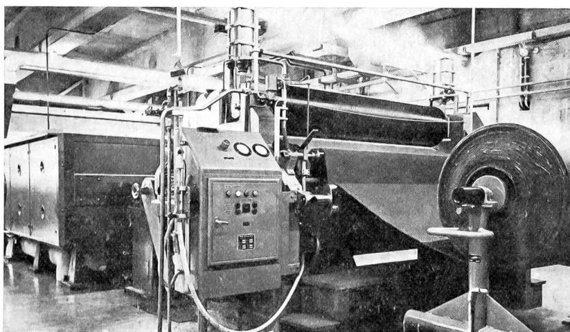
Foulard und Thermokanal zum Imprägnieren, Trocknen und Kondensieren von Nadelfilz-Bodenbelägen
