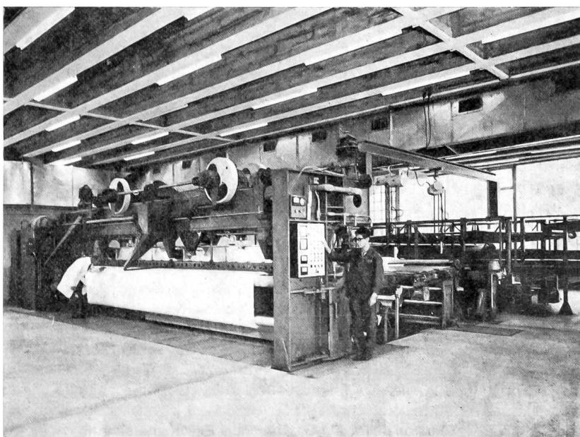
Elektronisch gesteuerte Nadelmaschine zur Herstellung von Faservliesen
