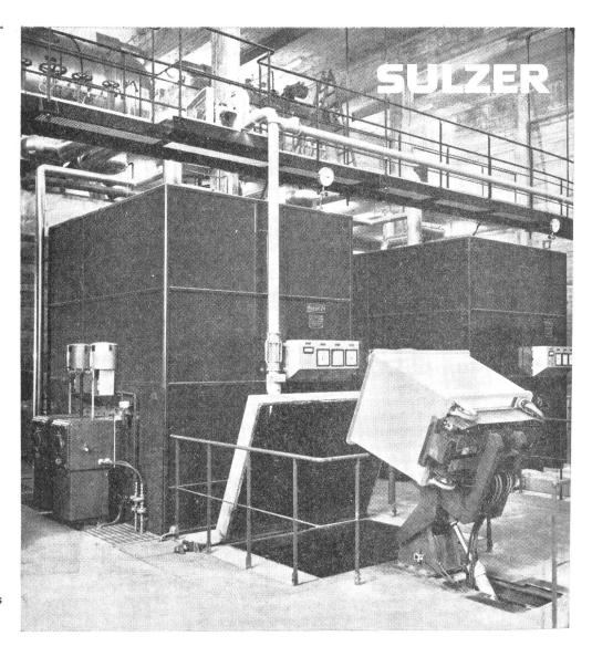
Heizzentrale eines Versandund Lagerhauses mit 2 Heißwasserröhrenkesseln von je 2,5 Mio kcal/h mit hydraulischer Kippvorrichtung für das Verbrennen verschiedenster Ahfälle.
