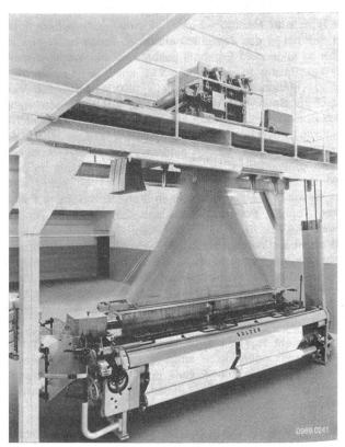
Sulzer-Vierfarben-Webmaschine 85 VSI 105 J mit Zangs-Jacquardmaschine
