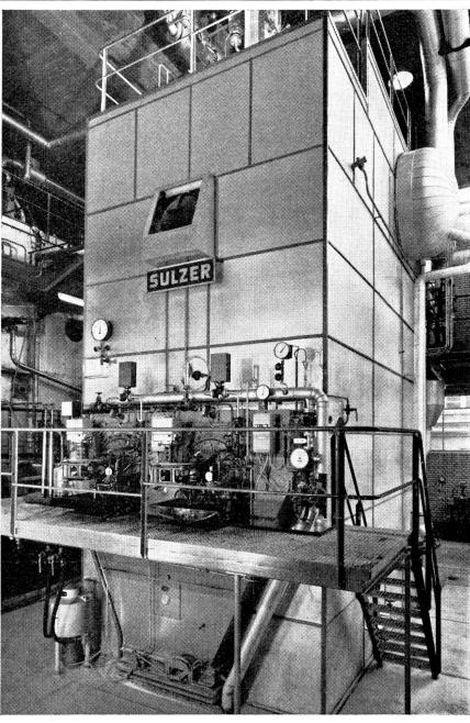
Sulzer-Hochleistungs-Strahlungskessel mit Überdruckfeuerung und Bedienungspodest für 2 Sulzer-Ölbrenner von je 800 kg Öl/h in einer Kartonfabrik. Kesseldaten: 16 bis 20 t/h, 41 atü, 425 °C.
