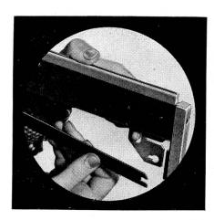
Durch ein Verschieben des Endstückes können die Aufreihschienen freigelegt und ausgeschwenkt werden. Dadurch können die Litzen rascher aufgereiht und abgestoßen werden.
