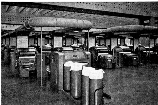
Ein weiteres Beispiel einer «Aerofeed»®-Anlage; im Vordergrund eine Rieter Regulierstrecke D 7 mit automatischem Kannenwechsler und Servo-Monitor (Bild 7)
